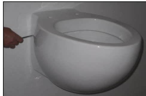
6 – Apertar os parafusos ajustando a bacia à parede .
