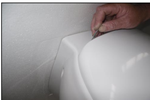
7 – Instalar o Tampo. Meter as tampas plásticas furos fixação bacia.
