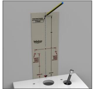
6 – Com a bitola centrada na sanita marcar o furo para instalação chapa.
