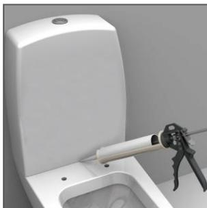
11 – Fazer duas descargas para verificar se há fugas de água e de seguida selar o tanque com silicone na base de contacto com a sanita.
