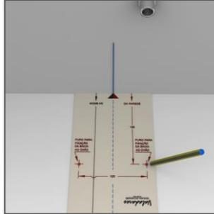
2 – Com a bitola centrada na linha (centro do esgoto) marcar os pontos para instalação kit fixação.
